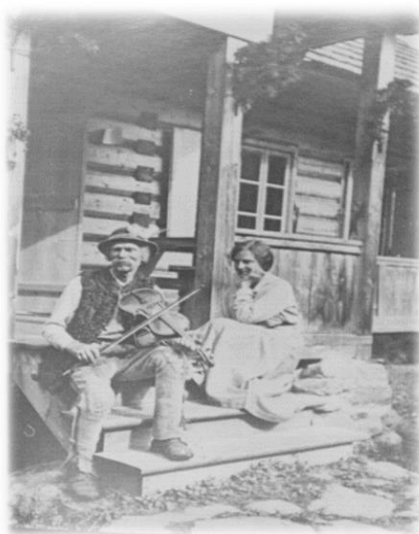
Ryc. 24. Helena Dłuska i przewodnik Bartłomiej Obrochta
